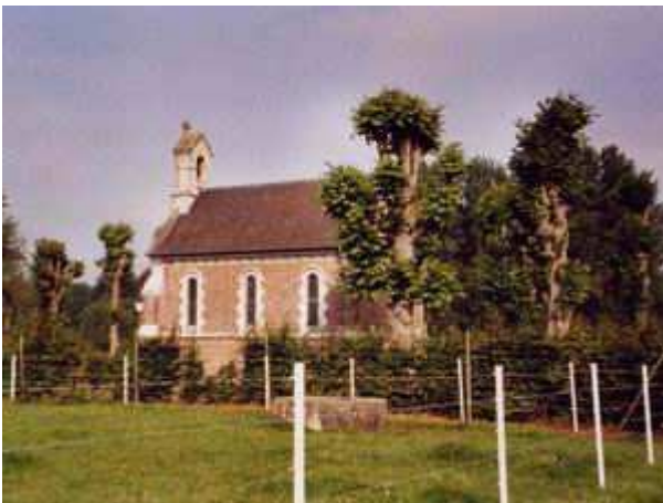
Vue de la chapelle
